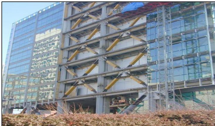
**Figura 6.** BRB en edificio. Fuente: Surendran & Varma, 2017
