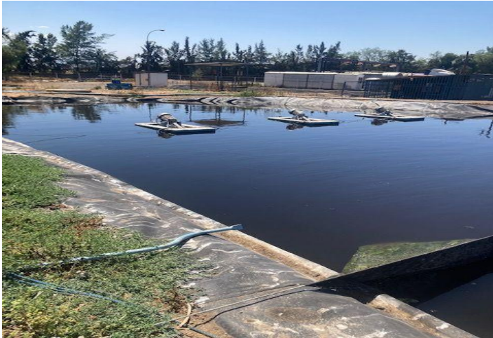
Figura 20: Aireador tornado equipado con motor de 3 Hp. (Recuperado: Carreño. C, 2022)
