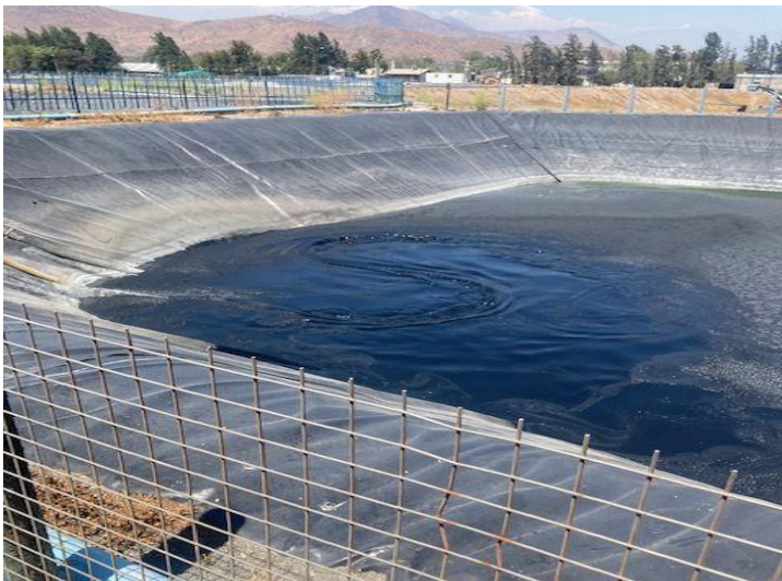
Figura 21: Piscina de espesamiento de los lodos. (Recuperado: Carreño. C, 2022)
