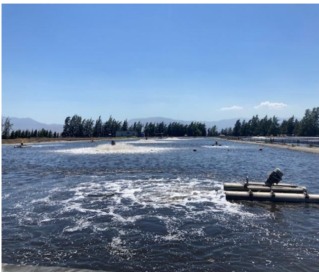
Figura 15: Lagunas aireadas (Recuperado: Carreño. C, 2022)
