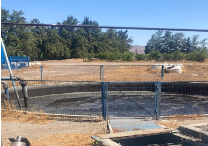
Figura 22: Piscina acumuladora de lodos. (Recuperado: Carreño. C, 2022)
