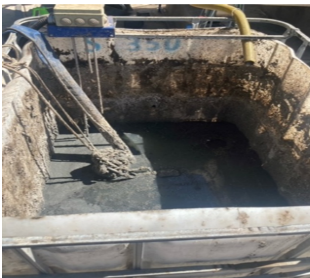
Figura 13: Eliminación de grasas. (Recuperado: Carreño. C, 2022)
